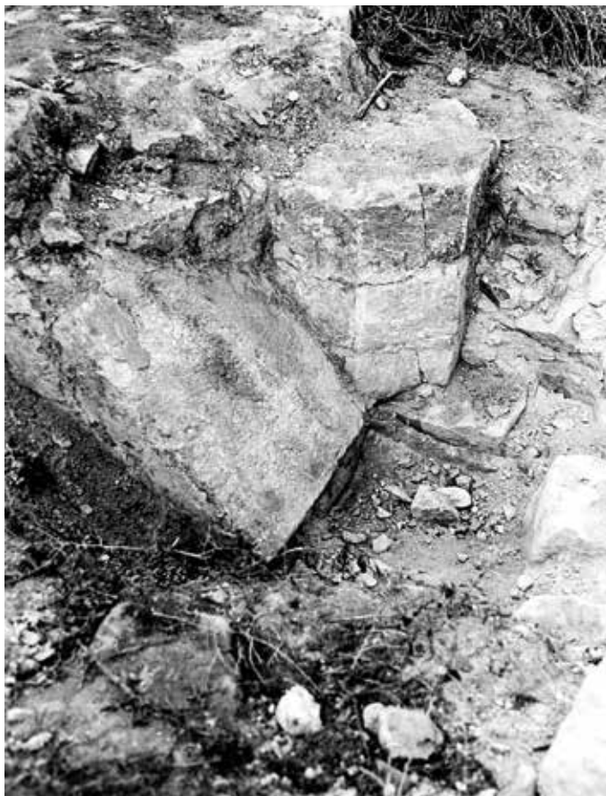
Ilustracja 9. Bodzentyn – zamek, badania archeologiczno-architektoniczne (1963-1983): kaplica, odkryty fragment muru z ciosów kamiennych ze służką – 1 ćw. XVI w. widok od wschodu. Fot. J. Langda 1963, zb. WUKZ w Kielcach
