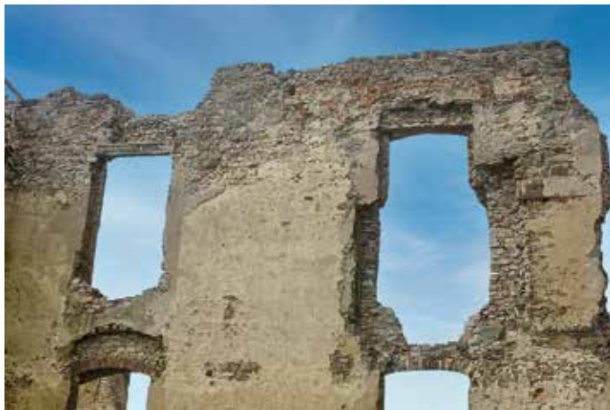
Ilustracja 25. Bodzentyn – ruiny zamku/pałacu, korpus główny po konserwacji murów wg projektu M. Brykowskiej; fragment II p., widok od wschodu. Fot. M. Brykowska 1983
