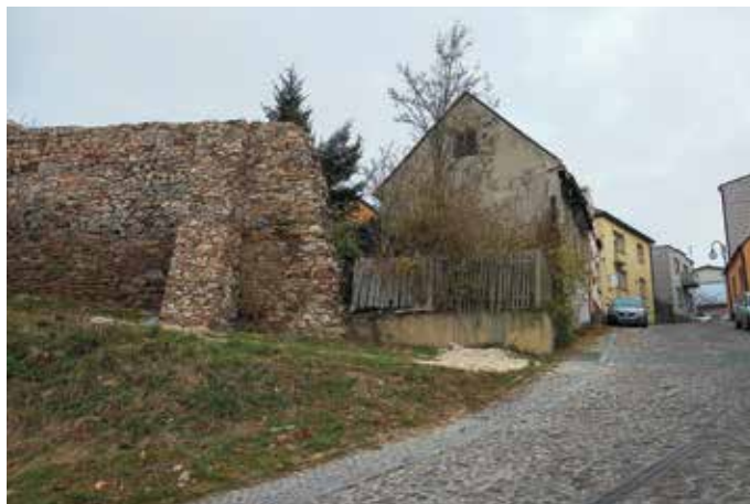
Ilustracja 26. Bodzentyn, mury obronne XIV-XVI w. po konserwacji, część północna przy niezachowanej bramie Krakowskiej, widok od południa. Fot. E. Brykowska-Liniecka 2015
